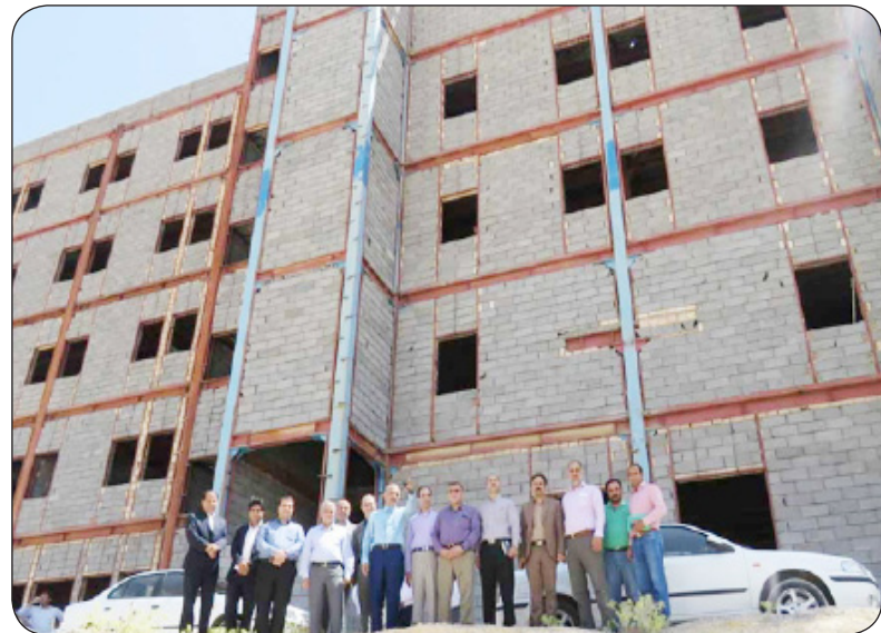
بازدید مسئولین دانشگاه علوم پزشکی ایلام به همراه بنیاد برکت از ساختمان دی کلینیک در حال احداث شهرستان ملکشاهی
